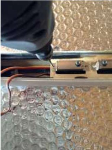
....um die Servos mit den beiliegenden Kreuzschlitzschrauben zu montieren.
